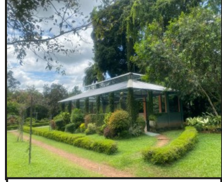
ஹெனரத்கொட யு.யு. புதுப்பிக்கப்பட்ட ஆலை வீடு
