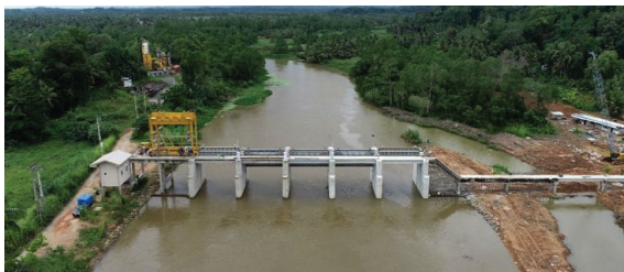
රූපය 4: නිල්වලා ගඟ හරහා ඉදිකර ඇති ස්ථිර ලවණ බාධකය
