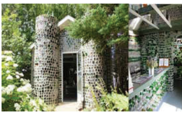
රූපය 18: සිංගප්පූරු නාක්ෂණය භාවිතා කටමින් පසු භාවිත වීදුරු බෝතල් යොදාගනිමින් නිර්මාණ කළ ගොඩනැගිල්ලක්
